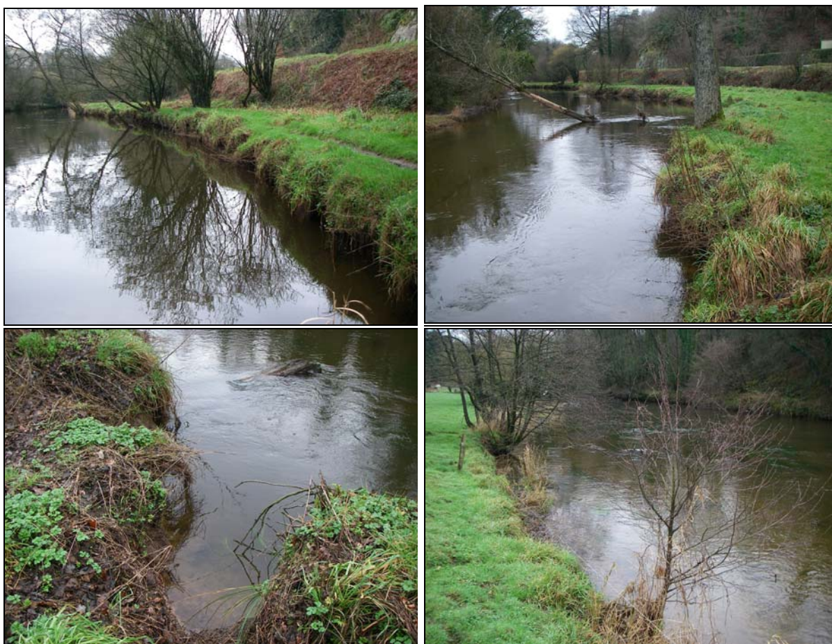
L'action cumulée des terriers des rats musqués/ragondins, du piétinement des bovins, de l'absence de ripisylve et de l'érosion lors des crues engendre des effondrements et des érosions de berge
