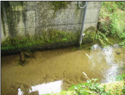
Sables en amont d'un ouvrage sur le Mougau Bihan
