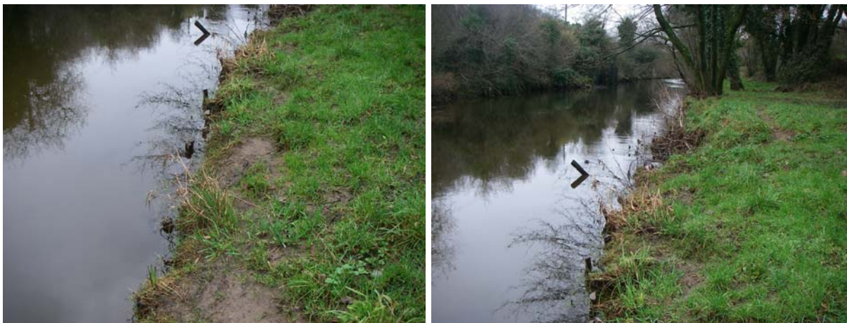
Berge renforcée par la mise en place de fagots de branches denses entre des pieux battus et la berge. Le dispositif est recouvert d'une couche de terre végétale et est ensemencé (travaux AAPPMA Elorn).
