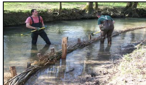
Autre technique : le fascinage qui consiste à tresser des branches de saules entre des pieux battus.
