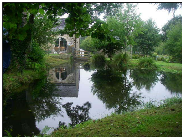
Ligne d'eau altérée en amont du moulin de Gollen
