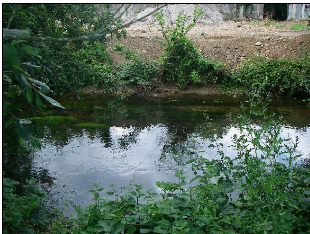
Lit majeur récemment remblayé sur l'Elorn.
