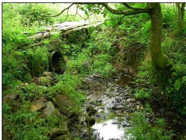
*Ce passage busé en très mauvais état sur le ruisseau de Dour ar Men Glaz est à remplacer par une passerelle*
