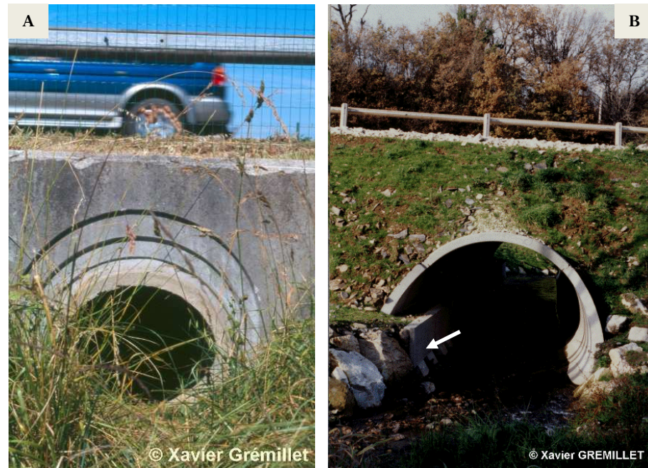
Dispositifs complémentaires pour l'aménagement des ponts A: Un grillage fonctionnel (enterré) au dessus d'une buse sèche (à gauche) B: Déflecteurs de courant à la base d'une banquette béton (à droite – déflecteurs indiqués par la flèche)
